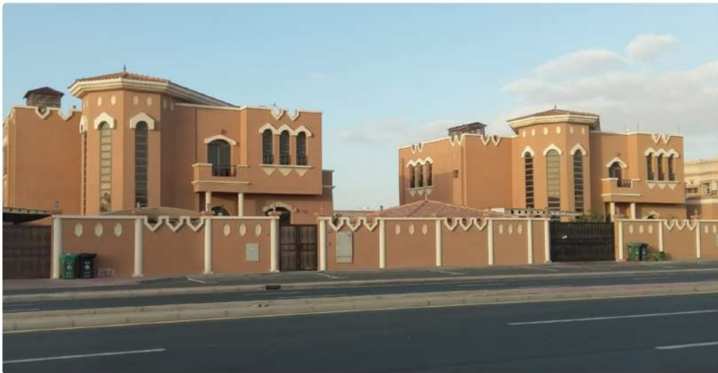
G+1 Villas + SB Al Barsha 2
