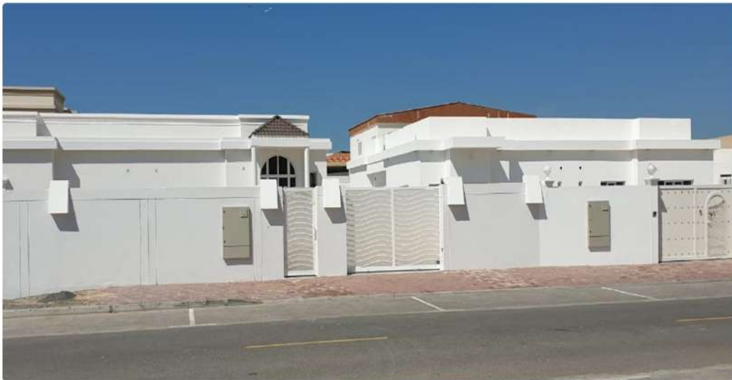
GF Villa + SB Al Sufouh 1
